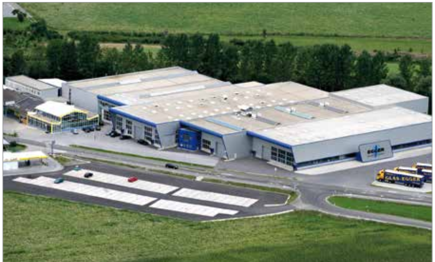
Egger Glas, ein Unternehmen mit 200 Mitarbeitern an 5 Standorten, produziert Sicherheits- und Isolierglas. Zur Montage sind eigene Teams vorwiegend in Ostösterreich unterwegs.
